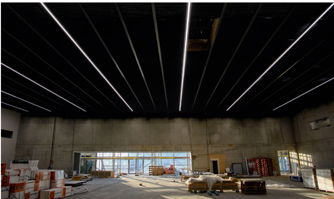
Große Saalhöhe und parallele Wandflächen sind raumakustische Hindernisse, die später durch schallabsorbierend geschlitzte Holzoberflächen an einer Längs- und Querwand überwunden werden.
